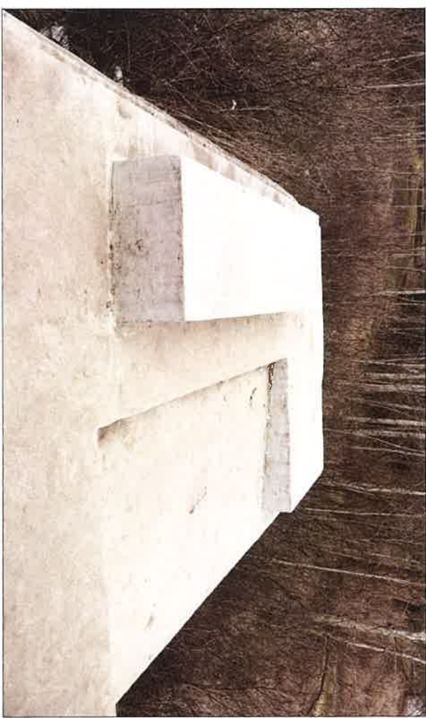
Filar mostu od strony zachodniej (Góry Kalwarii) z blokami żelbetowymi pod łożyska i dźwigary drugiej części mostu. (fot. Jakub Andrzejewski, 2021 r.)
