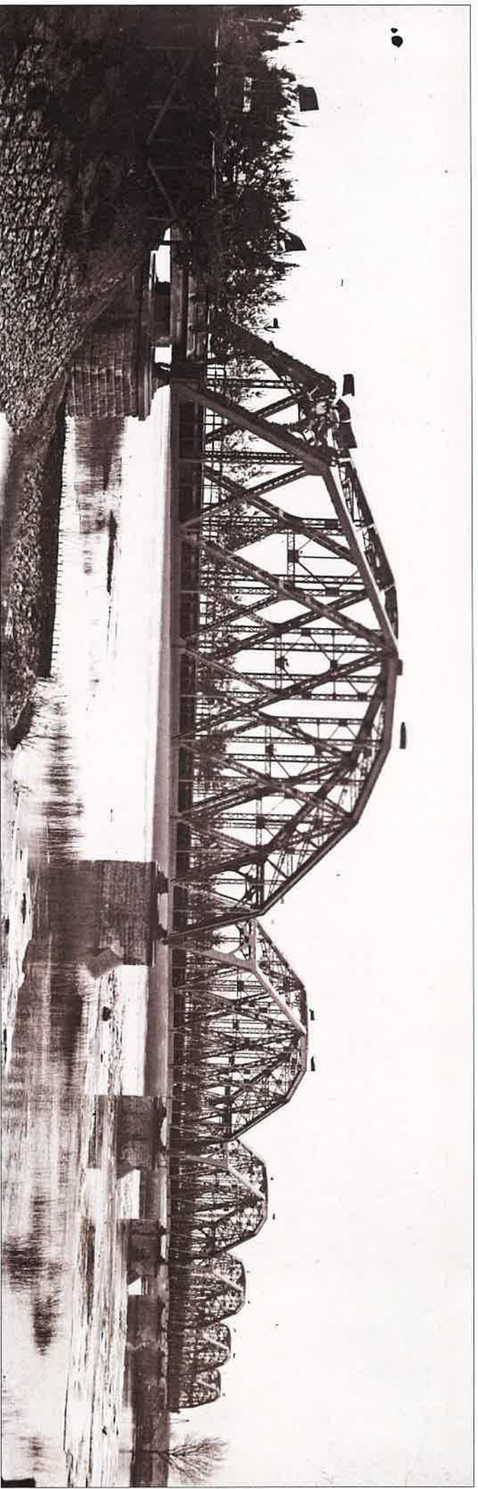
Most kolejowy w Sandomierzu, fotografie wykonano podczas otwarcia mostu w lutym 1928 r. Most wygląda identycznie jak ten wybudowany w Górze Kalwarii, różni się jednak rozpiętością przęseł głównych. W Sandomierzu przęsa główne mają rozpiętość 72 m, a w Górze Kalwarii 98 m. (źródło: https://audiovis.nac.gov.pl/sygn.1-G-3474-1 )
