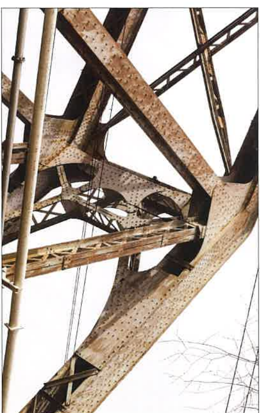
Tężnik poprzeczny usztywniający początek pasa górnego kratownicy powyżej skrajni i instalacji trakcji elektrycznej. (fot. Jakub Andrzejewski, 2021 r.)
