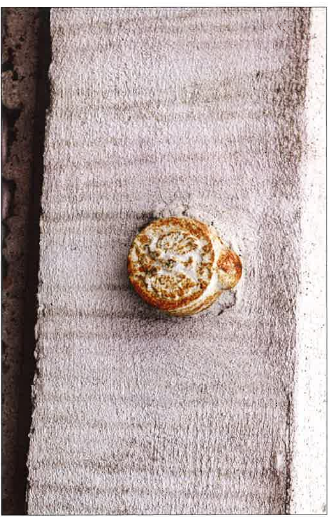
Reper wysokościowy umieszczony w zachodnim przyczółku po stronie południowej. (fot. Jakub Andrzejewski, 2021 r.)
