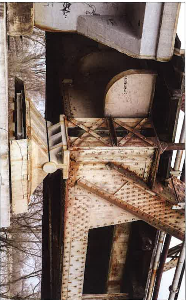
Filar mostu na kłonym oparte są dźwigary żelbetowy i stalowy. Widoczne łozysko przesuwne pod stalowym dźwigarem. (fot. Jakub Andrzejewski, 2021 r.)
