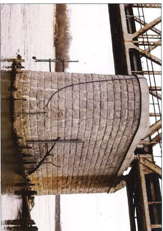
Widok drugiego filara mostu od strony północnej (fot. Jakub Andrzejewski, 2021 r.)
