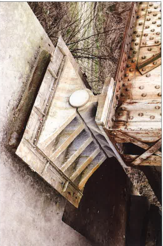
Łożysko przesuwne na filarze po stronie zachodniej. (fot. Jakub Andrzejewski, 2021 r.)
