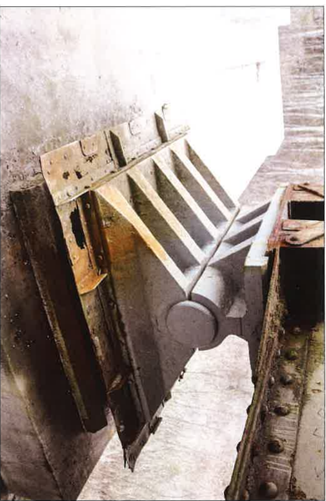
Łożysko przesuwne na filarze po stronie zachodniej. (fot. Jakub Andrzejewski, 2021 r.)
